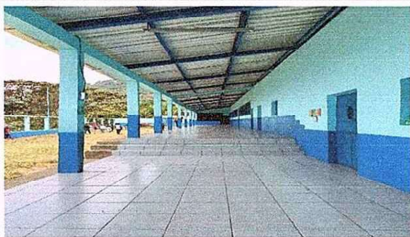
Foto1: Se observa el cambio de piso de concreto a piso cerámico.
