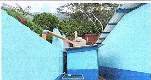
Foto 3: Se observa la instalación de una cisterna de 1,200 litros.
