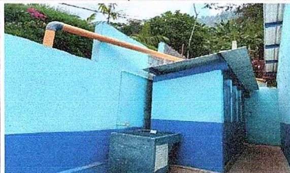
Foto 2: Se observa la instalación de una pila de concreto.
