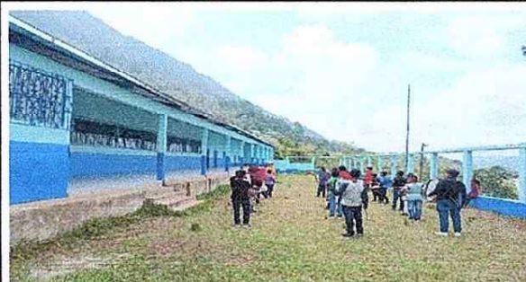
Foto 4: Se observa la aplicación de la nueva pintura en el muro perimetral.
